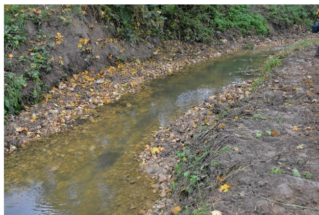
Photo du T3 pendant travaux – 19/10/2021
