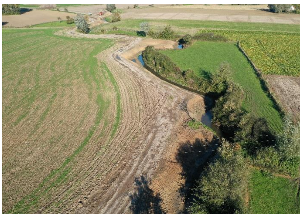
Photo aérienne du T3 après travaux – 28/10/2021
