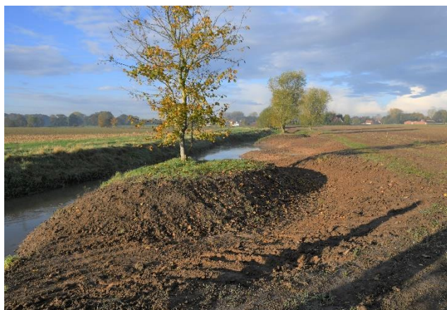
Photo du T3 après travaux (avant plantations) – 03/11/2021
