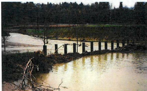
Figure 11 : Exemple de piège à flottants de type peigne
