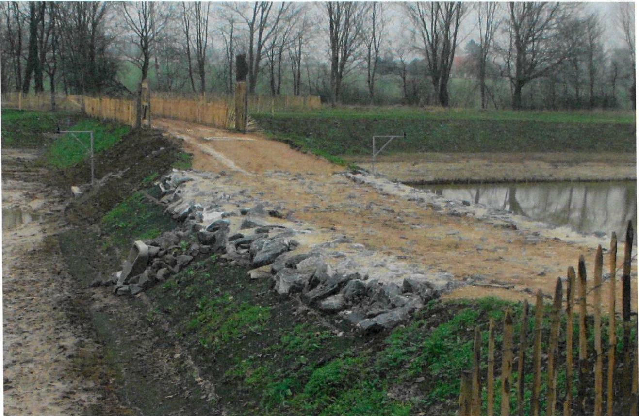
Figure 10 : Exemple de création de surverse de sécurité constituée d'enrochements liaisonnés
