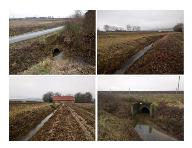
2 – A l'amont du TGV, un court tronçon bétonné d'une dizaine de mètres, apparemment à **l'intérieur de l'emprise SNCF mais non grillagée**, n'est plus en état d'assurer l'écoulement des eaux. Une grosse retenue d'eau s'y est formée
