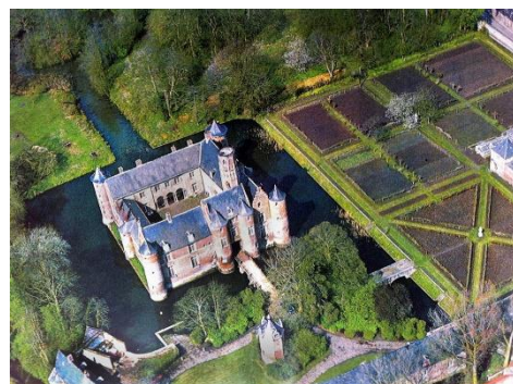
Figure 2: Vue aérienne du château et de ses douves
