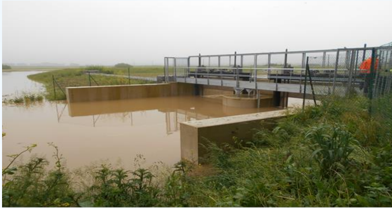
La cote maximale du vannage complètement déployée est de 18.53 m alors qu'elle doit être de 19,63 m
