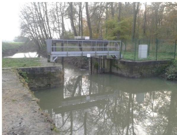
De ce fait, il a été décidé de réaliser une rivière de contournement au droit du barrage et d'adapter la gestion automatisée du barrage des Capucins à Merville pour rétablir la libre circulation des poissons.
