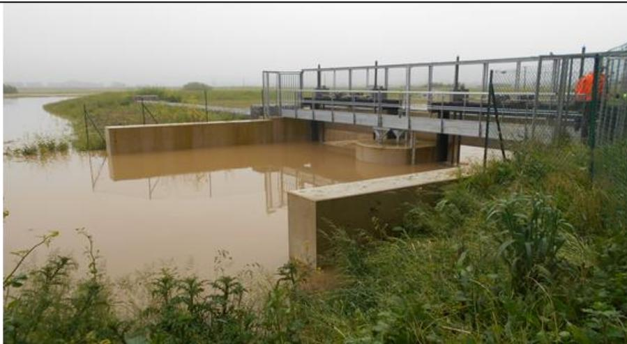
Dans l'arrêté préfectoral du 22 septembre 2010 modifié par l'arrêté du 6 juin 2012, l'article 1er précise que le volume de tamponnement est fixé à 95 900 m<sup>3</sup> pour le vannage n°1 et à 451 300 m<sup>3</sup> pour le vannage n°2, soit un volume total de 547 200 m<sup>3</sup>.
