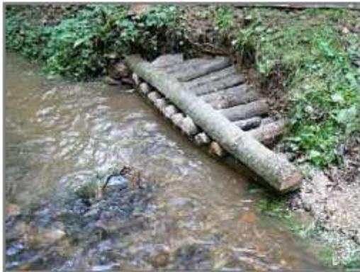
Sous-berge avec petite encoche dans la berge existante, avant recouvrement par de la terre végétale.
