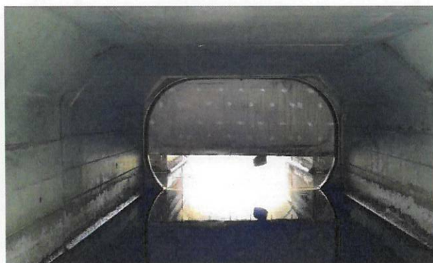
Figure 9 : Exemple d'ouvrage de régulation équipée d'une vanne dans le lit mineur d'un cours d'eau (Source : ARTELIA)
