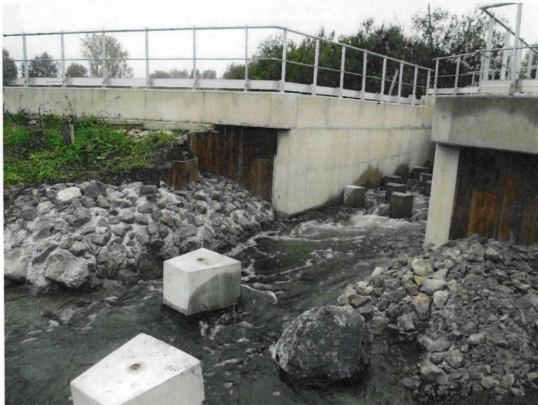
Fig. 2. Exemple de consolidation de berges constitué d'enrochements liés au béton (Source : ARTELIA)
