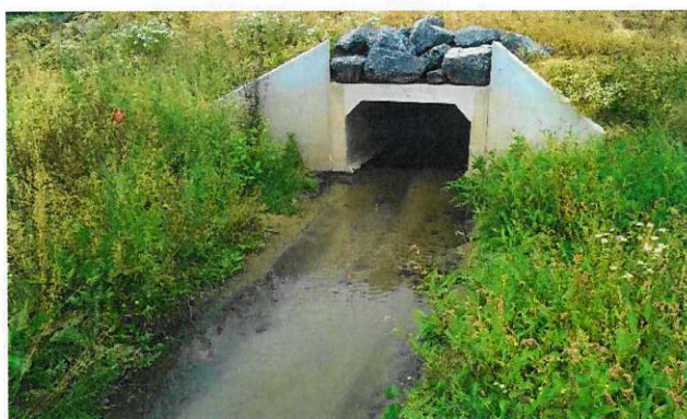
Figure 9 : Exemple d'ouvrage de régulation équipée d'une vanne dans le lit mineur d'un cours d'eau (Source : ARTELIA)
