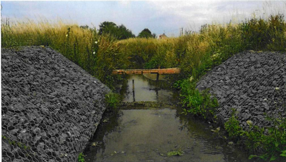
Fig. 1. Exemple de consolidation de berges constitué de matelas gabion (Source : ARTELIA)
