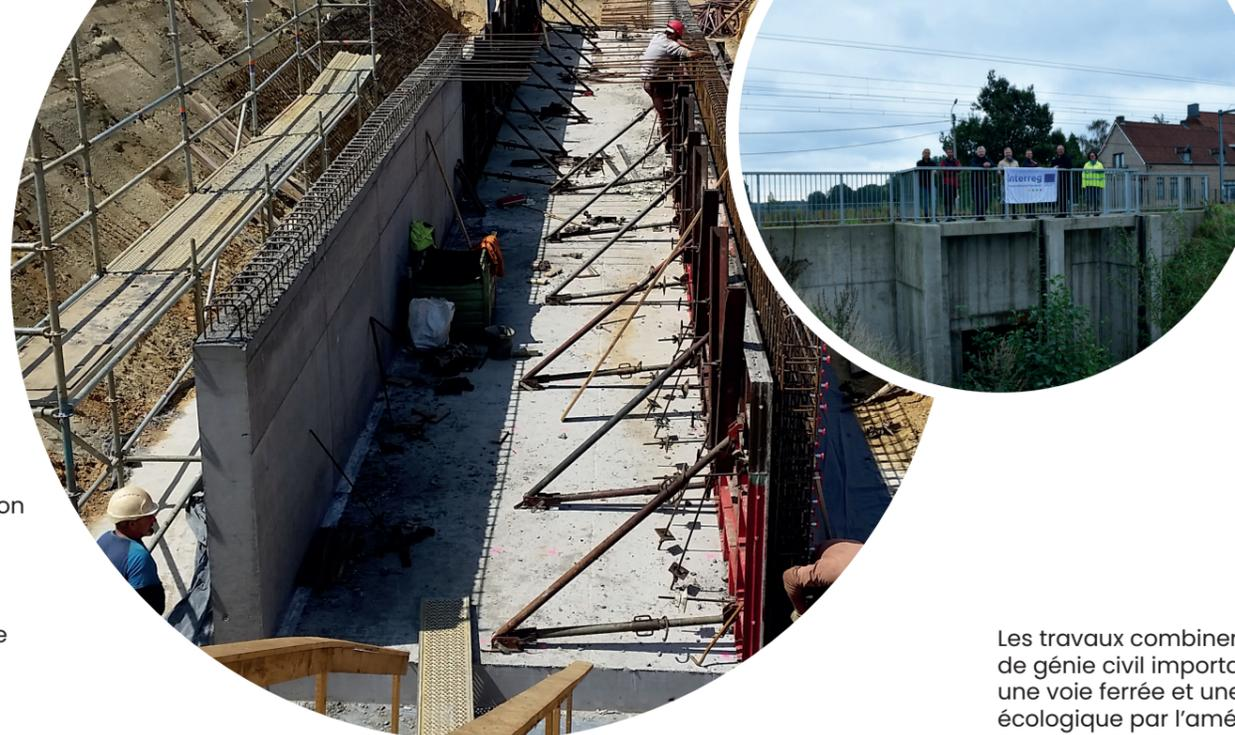
Les travaux combinent à la fois un ouvrage de génie civil important pour passer sous une voie ferrée et une route, et la restauration écologique par l'aménagement naturel de la liaison hydraulique.
