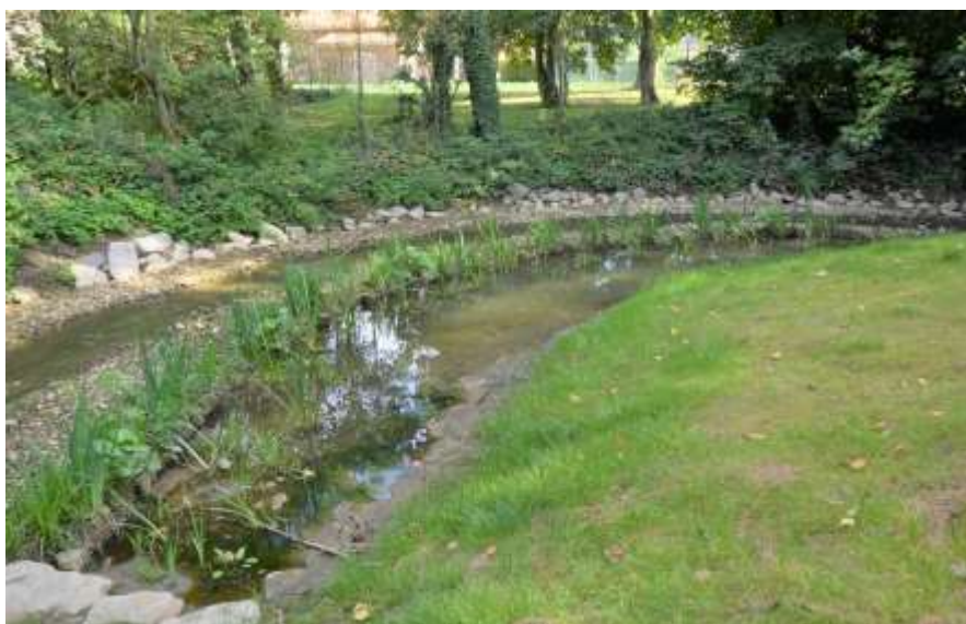
Becque avec la recharge en granulats, risberme basse à hélophyte fonctionnelle et berge couchée
