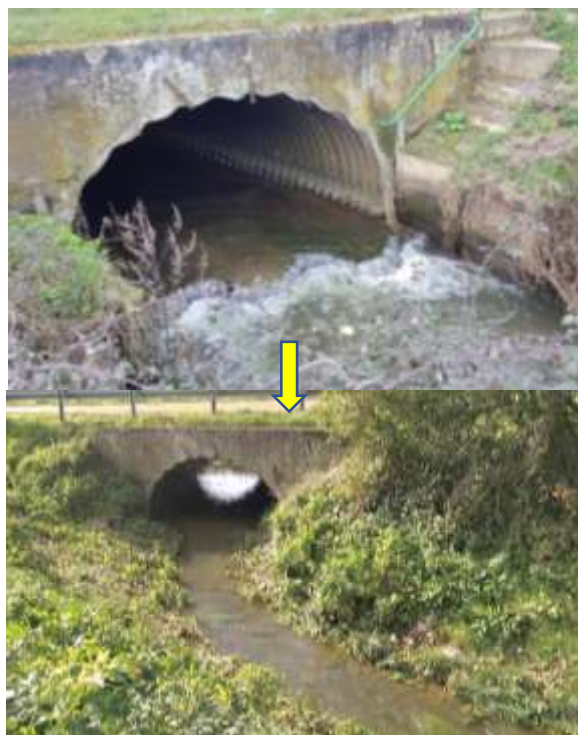
Seuil de pont sur la Sale becque à Oudezeele avant (Mars 2019) et après effacement (octobre 2020)
