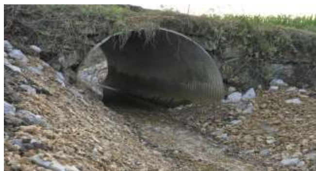
Seuil effacé sur la Becque d'Houtkerque à Herzele (octobre 2021)
