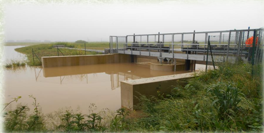
La cote maximale du vannage complètement déployée est de 18,53 m alors qu'elle doit être de 19,63 m
