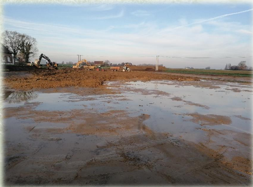
Travaux de terrassement en novembre 2020
