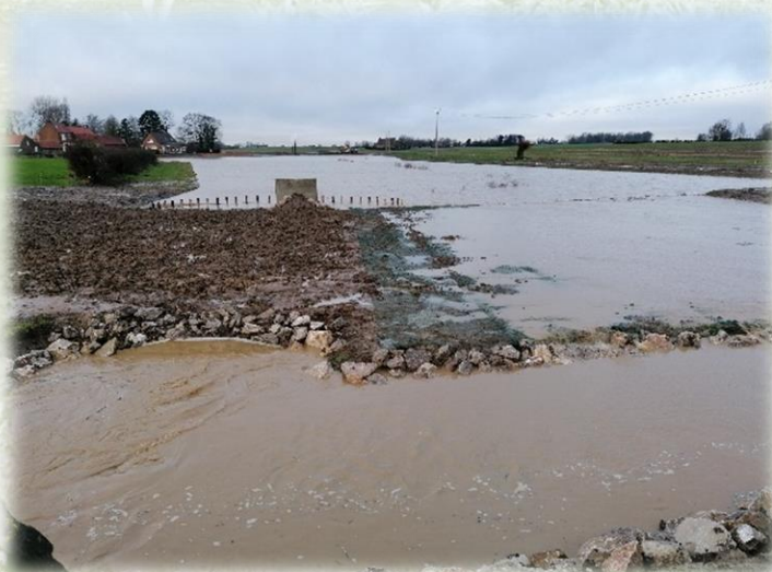
Mise en service fin décembre 2020
