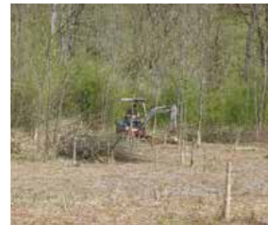
Figure 2 – Travaux printemps 2016 : dessouchage, creusement du lit et des mares
