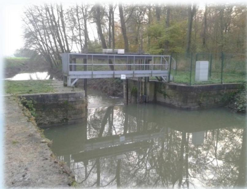
De ce fait, il a été décidé de déplacer le barrage en amont du sas existant en brique, de réaliser une rivière de contournement au droit du barrage et d'adapter la gestion automatisée du barrage des Capucins à Merville pour rétablir la libre circulation des poissons.
