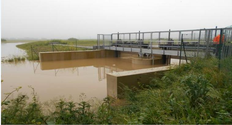
*La cote maximale du vannage complètement déployée est de 18.53 m alors qu'elle doit être de 19,63 m*
