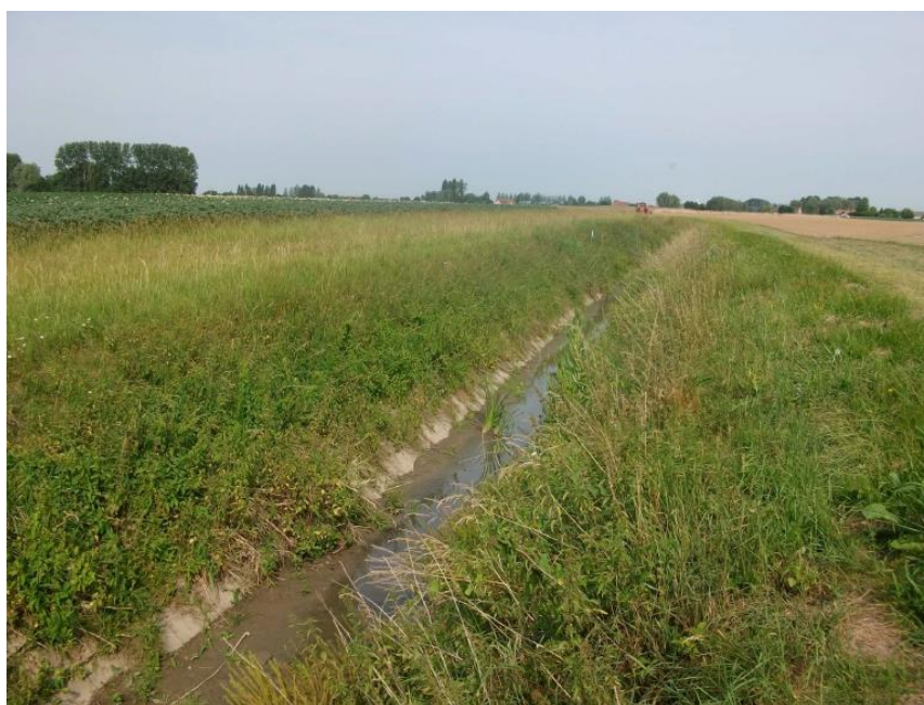
Photographie 8 La partie aval (La Gorgue) a perdu son caractère naturel : lit rectiligne sur plaque béton
