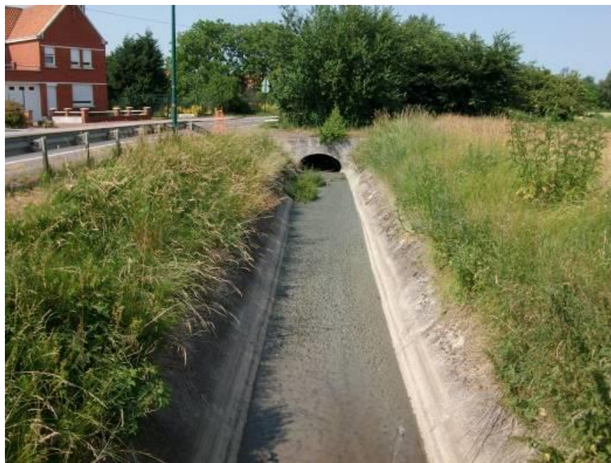
Photographie 3 Une grande partie du lit est artificialisée sur plaques
