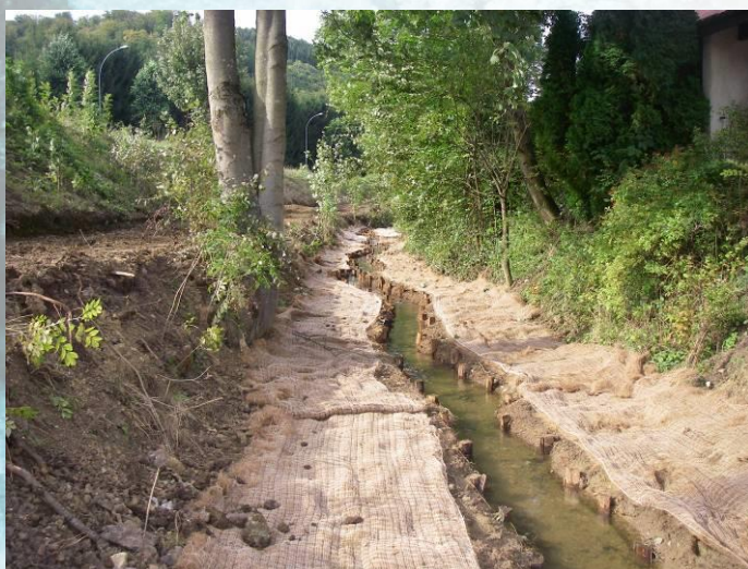
Exemple de lit mineur d'étiage créé dans la vallée de la Fensch (Moselle) en 2008-2009
