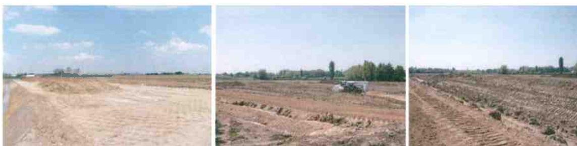
Travaux de constitution des nouvelles digues
