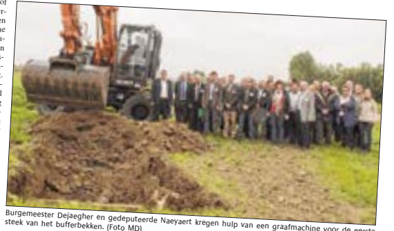
Burgemeester Dejaegher en gedeputeerde Naeyaert kregen hulp van een graafmachine voor de eerste steek van het bufferbekken. (Foto MD)
