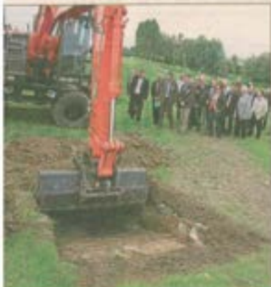
premier coup de pioche du futur bassin de Poperinge, le long de la Vlieter à Watou, a été donné mercredi par des élus locaux.
