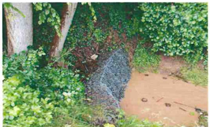
De ce fait, il est prévu de le réparer avec des palplanches métalliques qui seront perforées dans leur axe central et au radier du cours d'eau. En outre, il est prévu de réaliser une recharge granulométrique en amont et en aval du rideau de palplanches.
