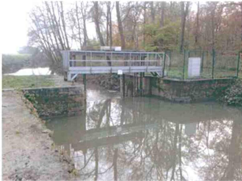
De ce fait, il a été décidé de réaliser une rivière de contournement au droit du barrage et d'adapter la gestion automatisée du barrage des Capucins à Merville pour rétablir la libre circulation des poissons.
